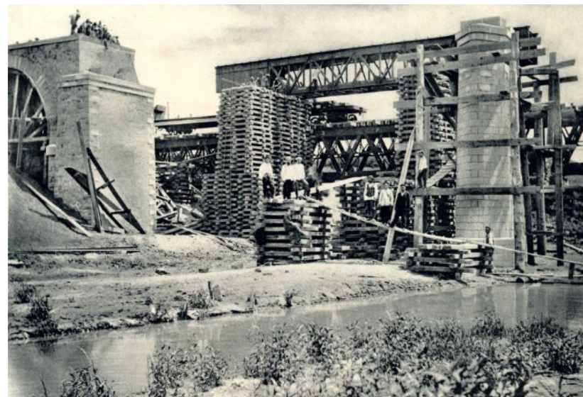
Сооружение моста на реке Пухэ. 1900-е гг.
