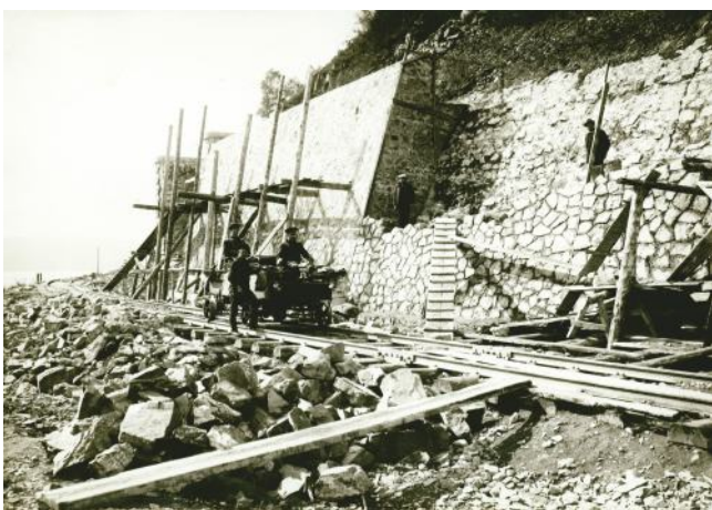
Укрепление скалы. Кругобайкальская железная дорога. 1901-1904 гг.
