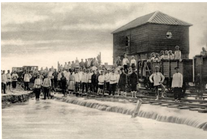
Повреждение пути наводнением на станции Ляоян. 1903 г.
