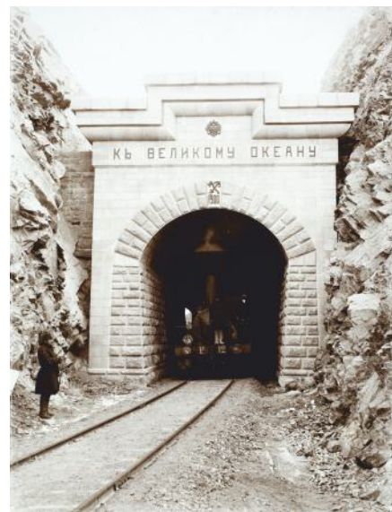
Портал тоннеля через Яблоневый хребет с западной стороны «К Великому океану». Забайкальская железная дорога. 1900 г.
