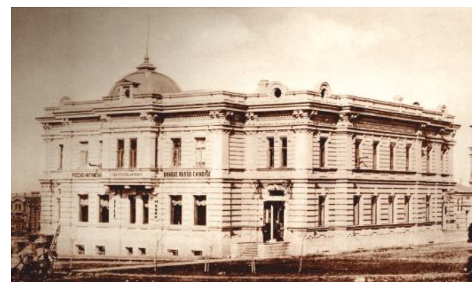
Здание Русско-Китайского банка на вокзальном проспекте в Харбине. 1900-е гг.
