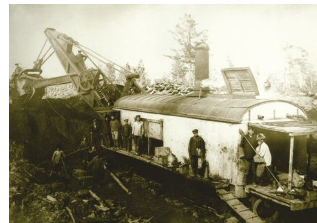
Экскаватор No 3 в выемке 424 версты. Средняя часть Амурской железной дороги. 1914 г.
