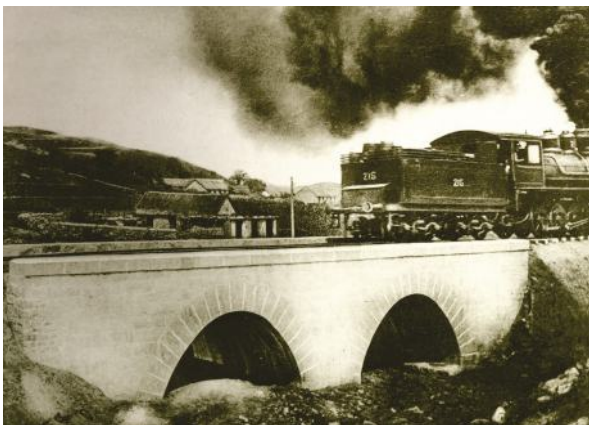
Двухпролетный каменный арочный мост отверстием 13 м на Южном отделении Китайско-Восточной железной дороги. 1900 г.
