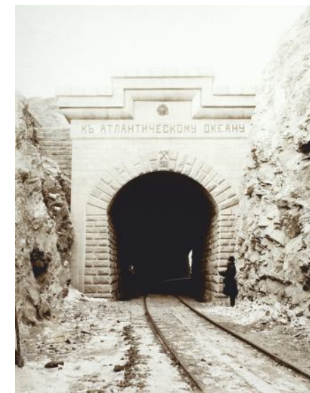
Портал тоннеля через Яблоневый хребет с восточной стороны «К Атлантическому океану». Забайкальская железная дорога. 1900 г.
