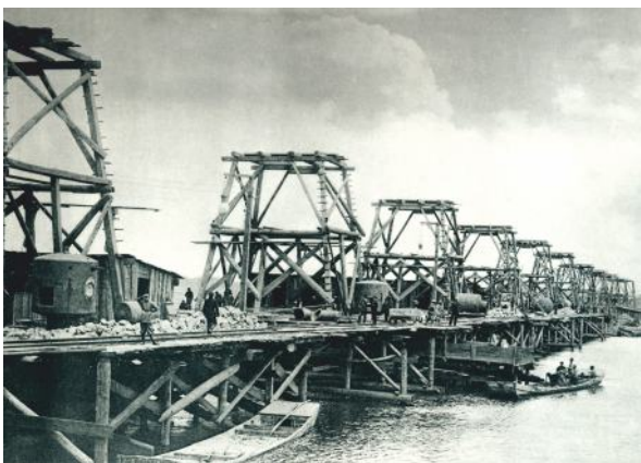
Установка кессонов при сооружении опор моста через реку Чинхэ. 1900-е гг.
