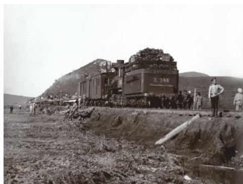
Ремонтные работы на трассе Китайско-Восточной железной дороги. 1910-е гг.
