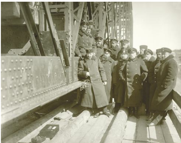
Мост через реку Обь. Испытание прогиба моста прибором Френкеля. Западно-Сибирская железная дорога. 1896 г.
