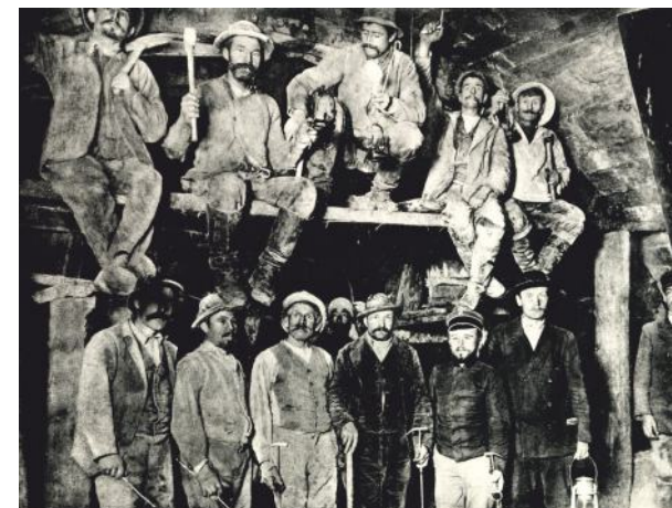
Итальянские рабочие на кладке свода Хинганского тоннеля. 1900-е гг.
