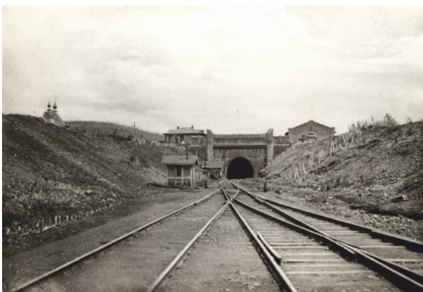
Западный портал Хинганского тоннеля. 1900-е гг.
