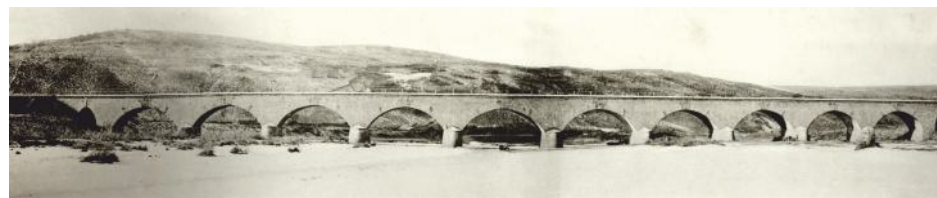
Каменный арочный мост через реку Мурен отверстием 128 м. 1900-е гг.
