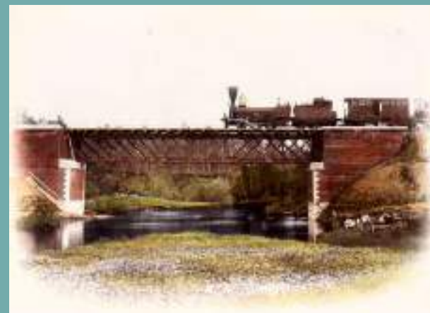
Мост через р. Нерль
