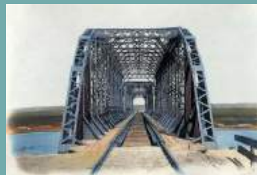
Мост через р. Березину (системы Шведлера). «Альбом видов Московско- Брестской железной дороги. 2-ой участок. Линия от Смоленска до Бреста». «Фотограф Его имп. Высочества М. Настюков в Москве». 1871 г.
