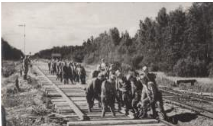
Укладка второго пути на подходе к станции Селище линии Ленинград - Москва. 1945 г.
