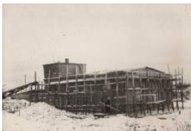
Окончание строительных работ по зданию электростанции на станции Чудово. 1945 г.
