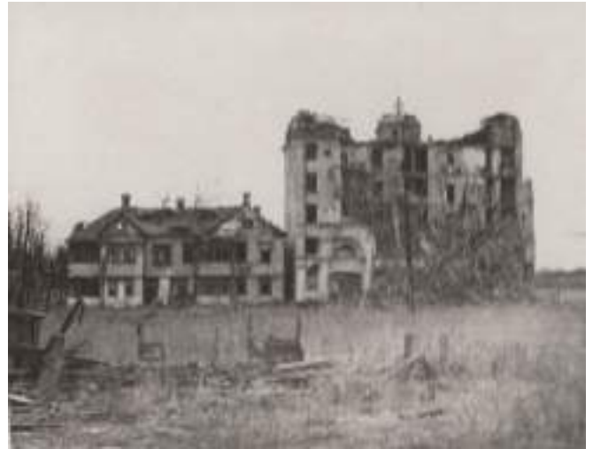
Разрушенные в результате авианалёта жилые дома при станции Детское Село. 1941 г.
