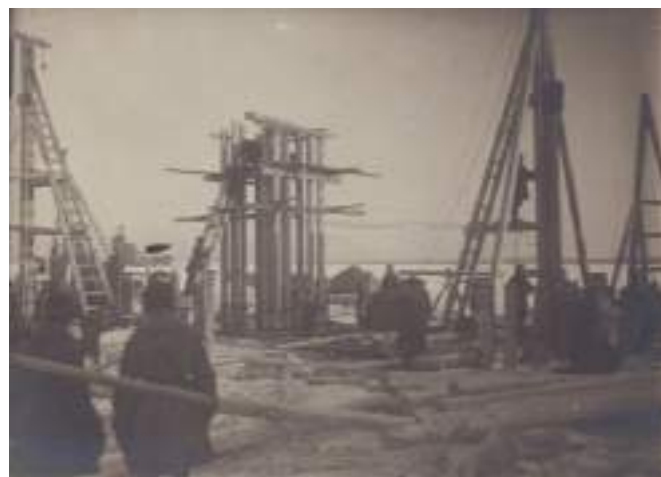
Строительство опор моста через Неву на трассе Поляны – Шлиссельбург. Январь 1943 г.
