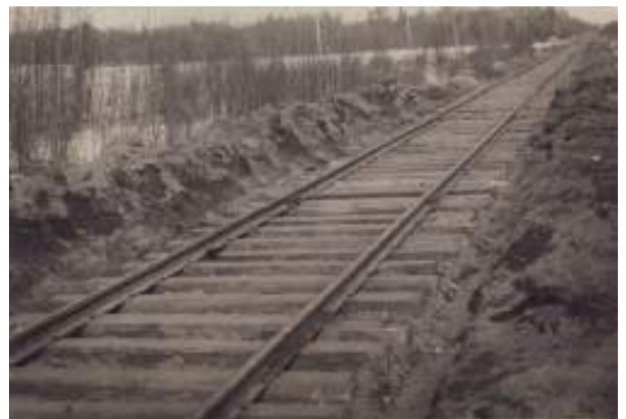
Восстановление пути на линии Веймарн-Сланцы. 1944 г.
