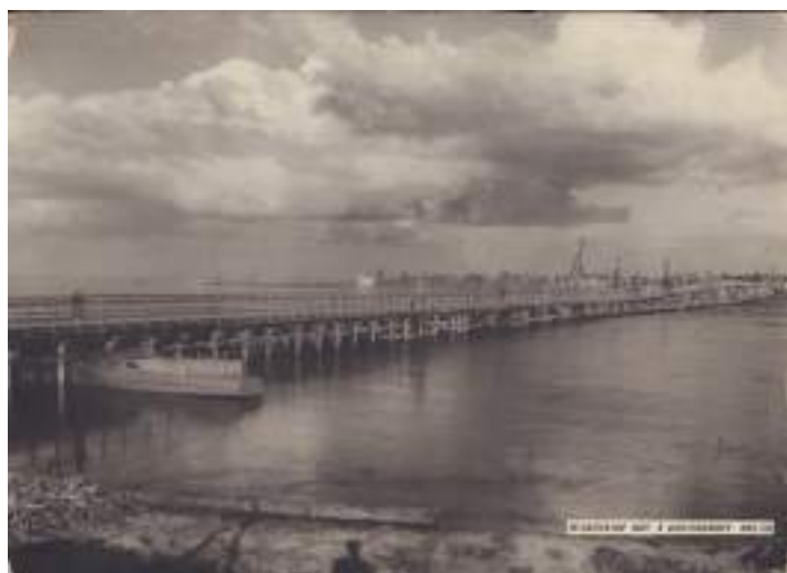
Строительство железной дороги Поляны – Шлиссельбург. Автомобильный мост через Неву у Петрокрепости. Фотограф – Г.И. Парицкий. 1943 г.
