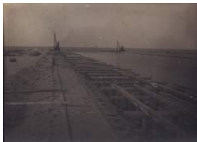
Строительство железной дороги Поляны – Шлиссельбург. Укладка прогонов на переправе через Неву. Январь 1943 г.
