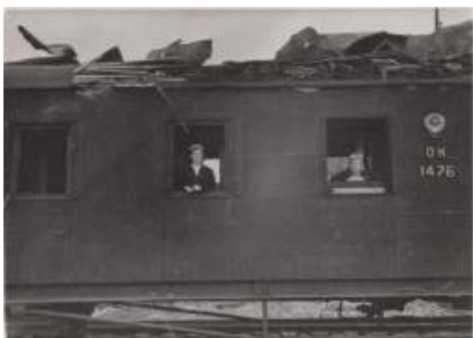
Разрушенный пассажирский вагон в депо Ленинград-Московский. 1941 г.
