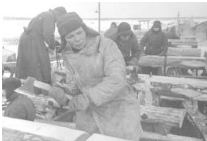
Строительство железнодорожного моста через Неву после прорыва блокады Ленинграда. Январь 1943 г. Из собрания Центрального государственного архива кинофотофонодокументов Санкт-Петербурга
