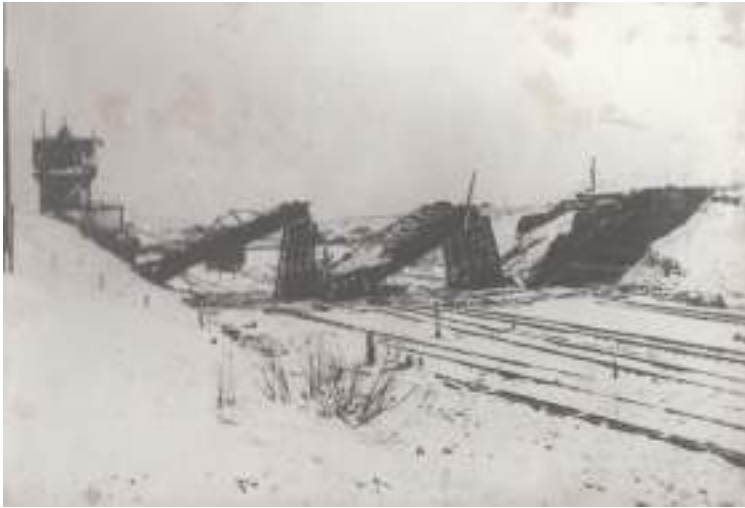
Разрушенный авианалётом путепровод на станции Красное Село. 1941 г.
