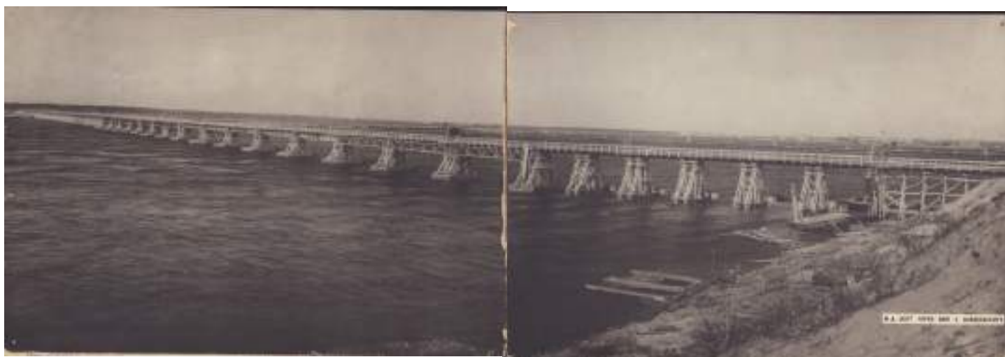
Строительство железной дороги Поляны – Шлиссельбург. Железнодорожный мост на линии Войбокало – Ленинград. Фотограф – Г.И. Парицкий. 1943 г.
