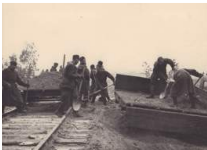
Строительство подъездных путей в бухте Осиновец. 1942 г.
