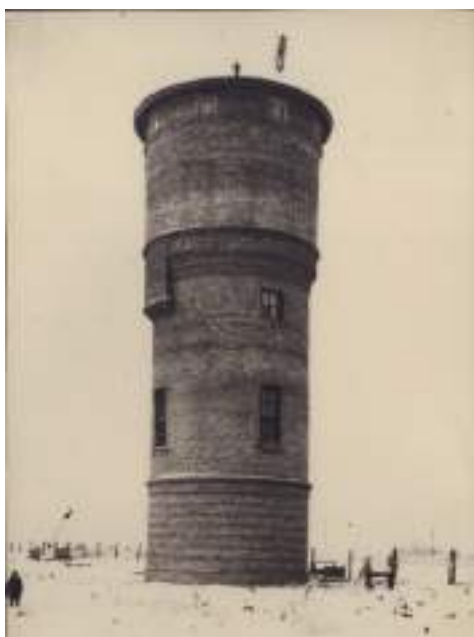
Вид восстановленной водонапорной башни на станции Мга. 1945 г.
