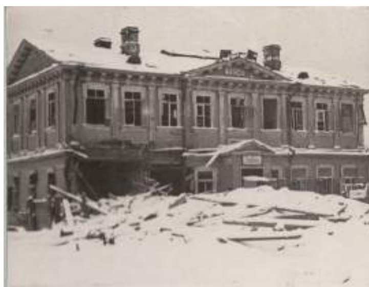
Разрушение пассажирского здания на станции Тосно. 1941 г.
