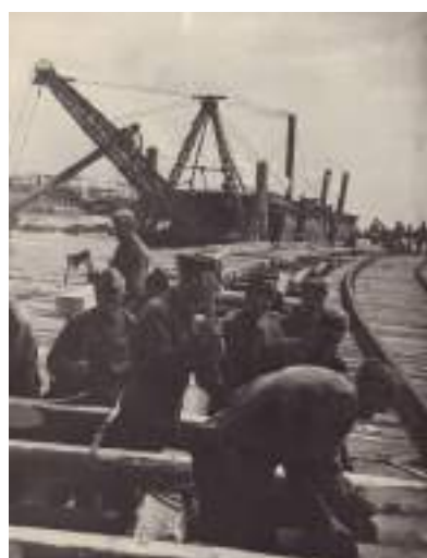
Порт Осиновец. Постройка подъездных путей на пирсе. 1942 г.
