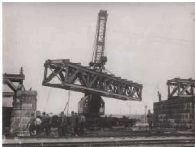
Эвакуация пролетного строения железнодорожного моста на линии Ленинград – Москва. 1941 г.
