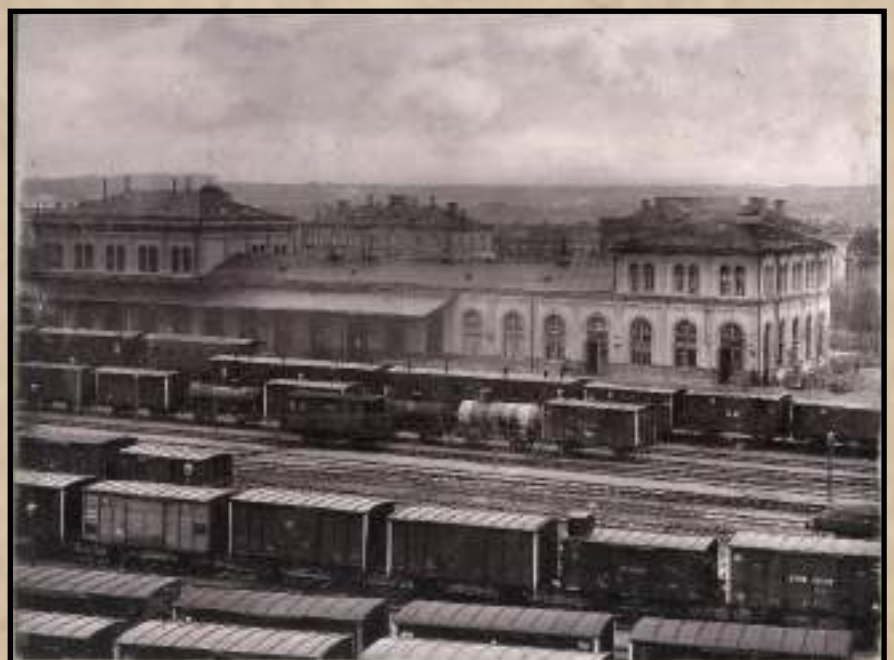
Станция Вильна Санкт-Петербургско-Варшавской железной дороги Конец XIX в.
