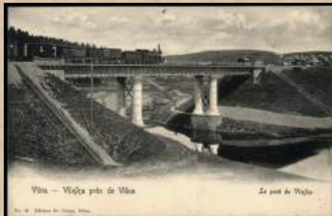
Мост через р. Вилия г. Вильна. Санкт-Петербурго-Варшавская железная дорога. Почтовая открытка. Начало XX в.
