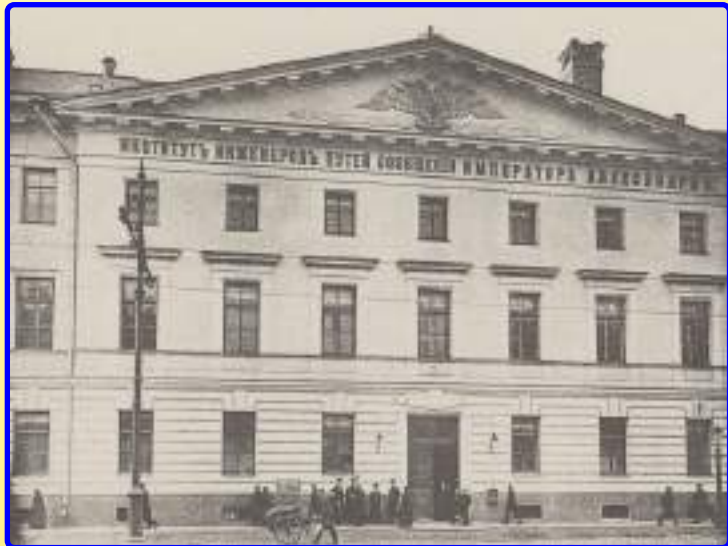
Фасад здания ИИПС.
