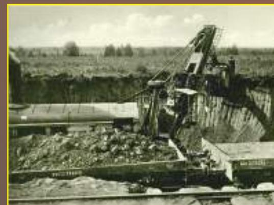
*Земляные работы при помощи экскаватора по переустройству горных участков Сибирской железной дороги. 1908 г.*
